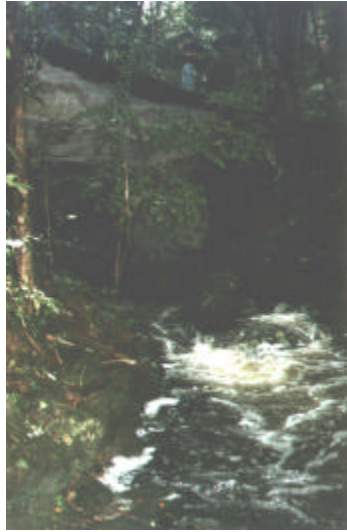
Fig. 2. Poço da Ponte Preta, Teresópolis, RJ.
