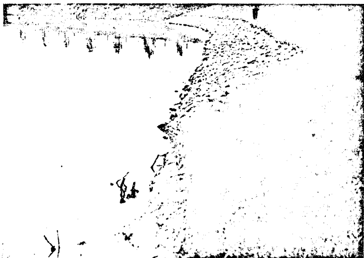
Abb. 1 Herzfeld. Neue Steinpackung, im Vordergrund Sandufer, im Hintergrund Phalaris -Bestände.
