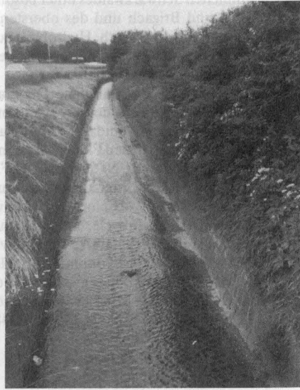
Fig. 3: Zähringer Dorfbach (ZÄH), vollständig vom natürlichen Untergrund abgeschnitten durch Pflastersteine und Betonschalen, außerdem häufiger Wechsel im Wasserstand bis zum Trockenfallen. Dieses zur Abflurrinne degradierte Fließgewässer ist entsprechend artenarm.
