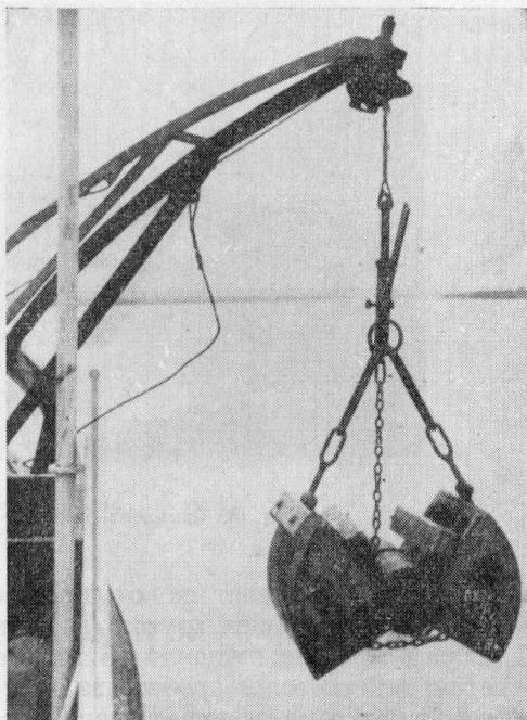
Фиг. 2. На работа с дъночерпател на Петерсен
