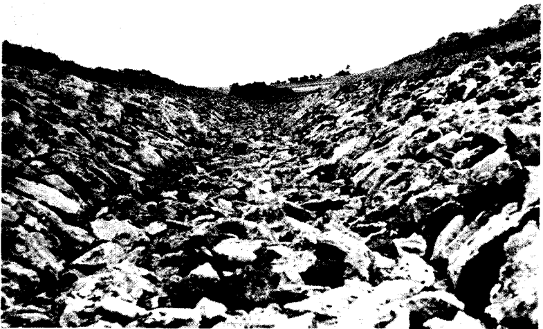
Abb. 6 Lauter, Steinschüttung des Reg (vor Bespannung).
